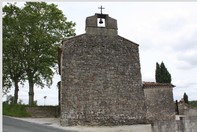
Le seul clochet mur de l'église de Bajos.
