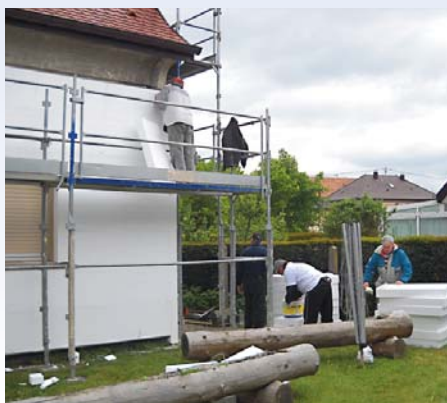
Des travaux d'isolation de la caserne.
