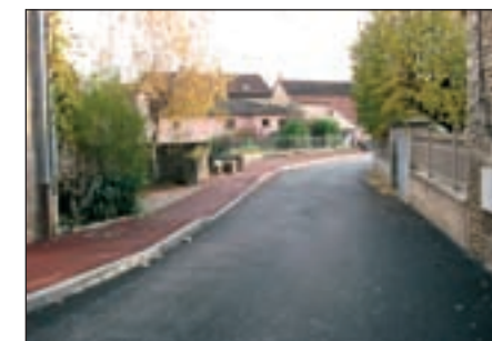
Lors de la pose des bordures
