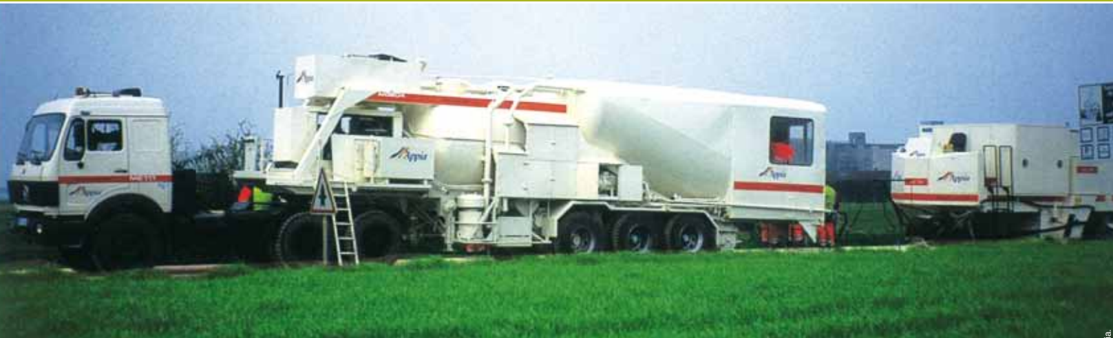
Une machine à recycler à froid en place, les enrobés : la fraiseuse, en tête, est suivie d'un malaxeur, dans lequel les enrobés fraisés sont mélangés à de l'émulsion ou de la mousse de bitume et des additifs. La remise en place est effectuée classiquement par un finisseur.
