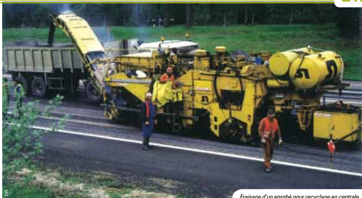
Fraisage d'un enrobé pour recyclage en centrale.
