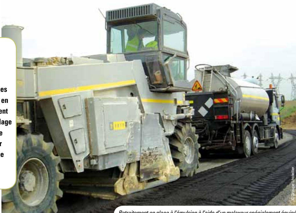
Retraitement en place à l'émulsion à l'aide d'un malaxeur spécialement équipé.
