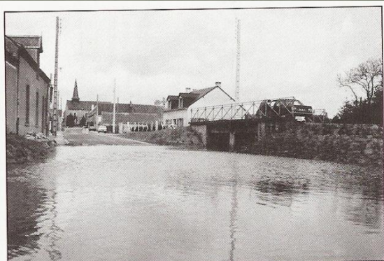
Pont du Bourg - 1983
