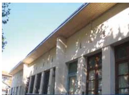
Elle a effectué la reprise des fuites, la suppression des cheminées sur la partie haute et le remplacement des plaques apparentes sur le bandeau avant.
