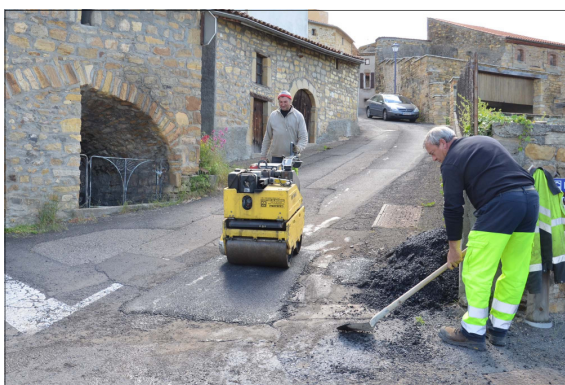
Rebouchage des nids de poule en cours de réalisation par le Sivom de l'Albaret
