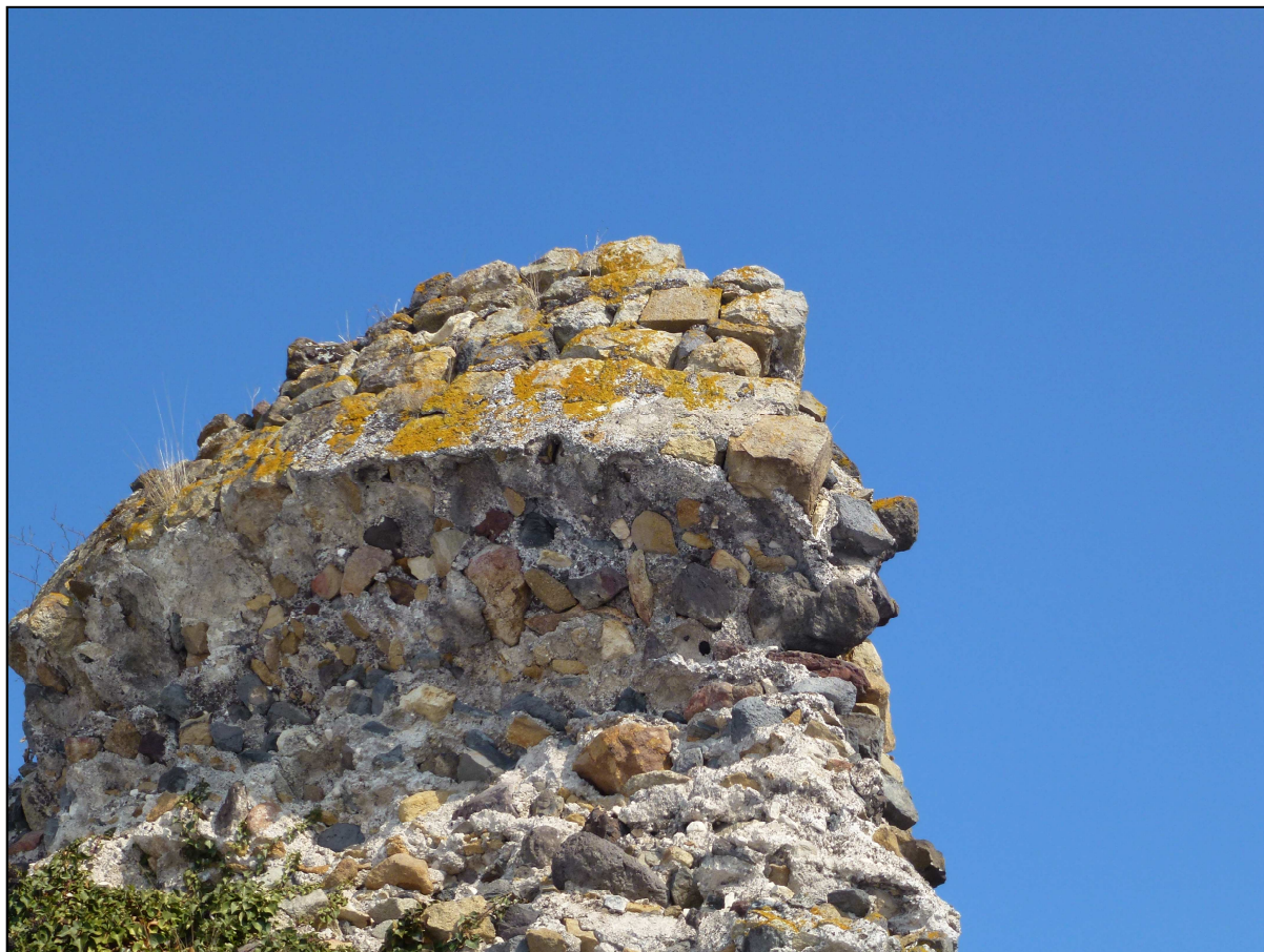
7.- Vue de détail du chaînage et du blocage (© Ulysse Cabezuelo)
