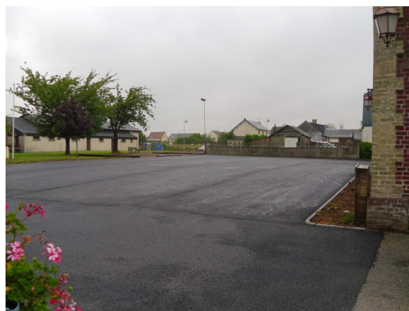
Après les travaux
