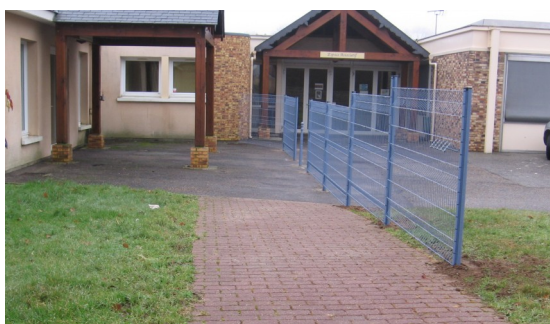
Clôture de la cour intérieure au niveau des salles annexes de la mairie
