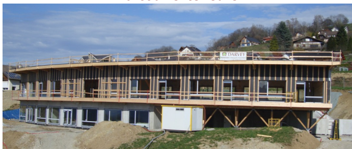
Le bâtiment prend forme
