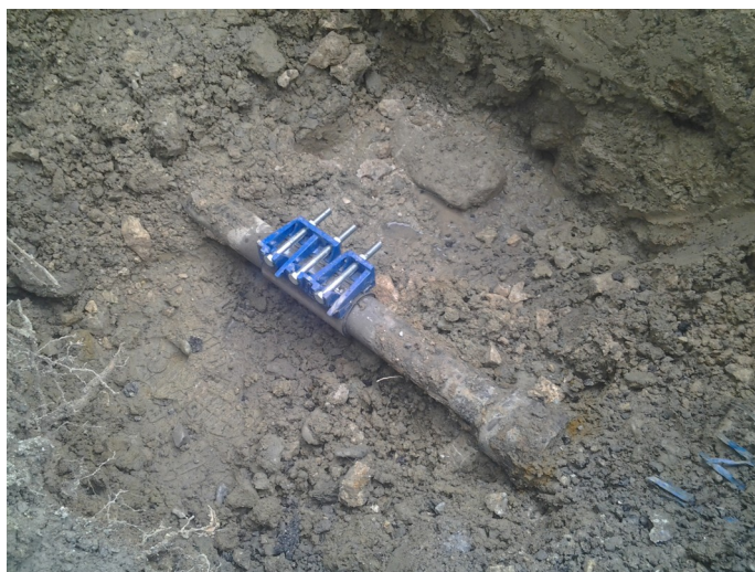
Réparation d'une fuite
