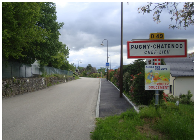
Trottoir route de Trévignin
