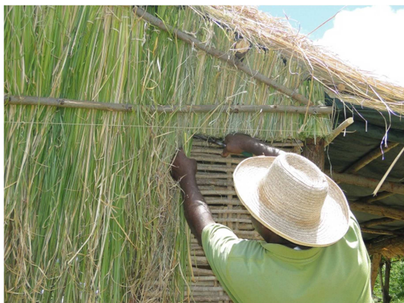
Les agents du service technique posant le vétiver sur les parois de la case
