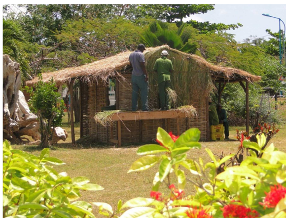
Les agents du service technique posant le vétiver sur les parois de la case
