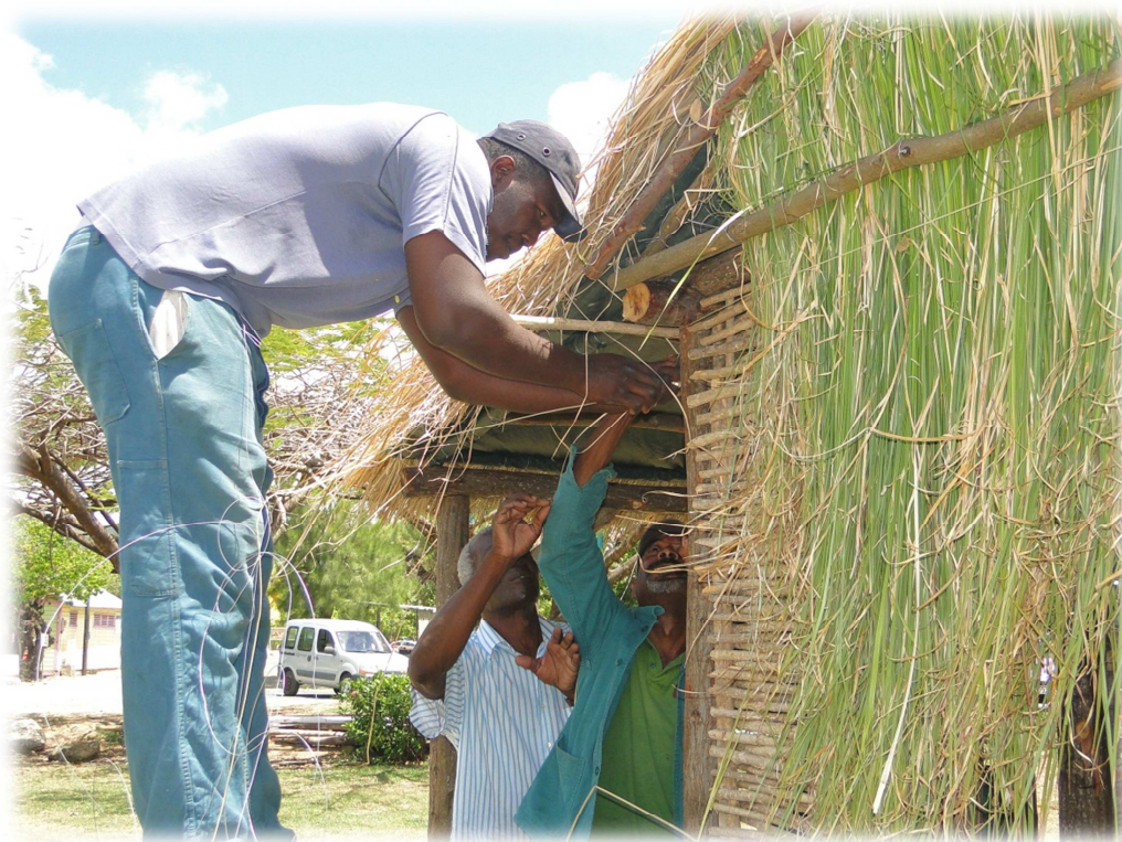
Les ouvriers à l'œuvre toujours sous l'œil attentif du Maître Ferdinand JAUNE.
