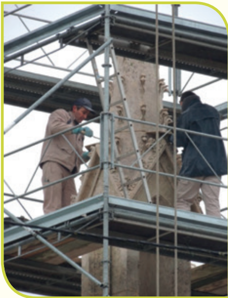
Pose et stabilisation du clocher
