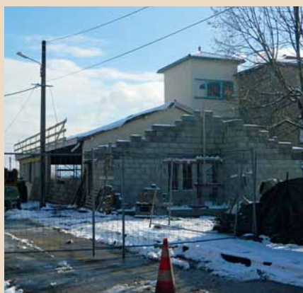
Travaux du restaurant scolaire
