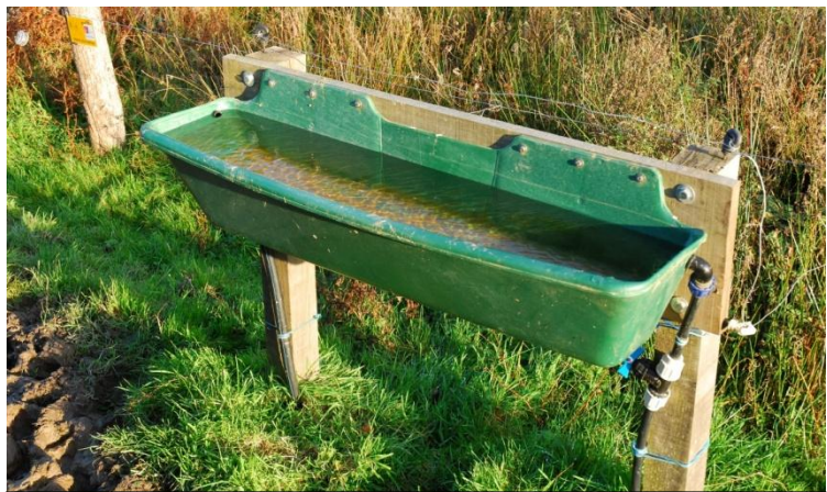
Abreuvoir de 60 L à débit permanent installé sur le chantier vitrine.
