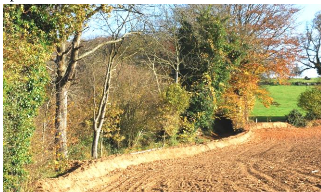
Restauration d'un talus à la Prioulais (St Mars sur la Futaie)
